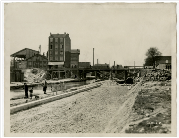
Figure 6: le canal de l'Ourcq en travaux au niveau du pont de la rue Delizy le 12 avril 1927. © Droits réservés / AD093
