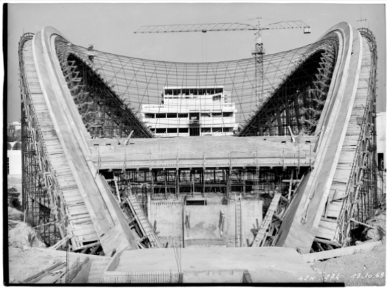
Figure 9 : 105FI/391 : chantier de construction du complexe sportif de l'île des Vannes à L'Île-Saint-Denis le 13 octobre 1969 © Henri Baranger – Établissements Henri Baranger – AD093
