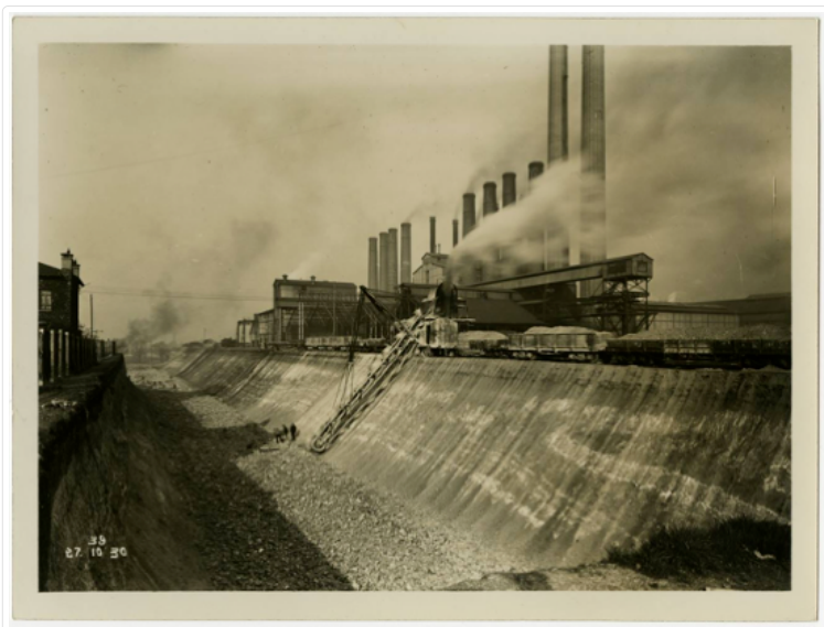
Figure 7: 155F1/74 - Le chantier de construction et les installations existantes de la centrale électrique de Saint-Denis. © Droits réservés/ AD093
