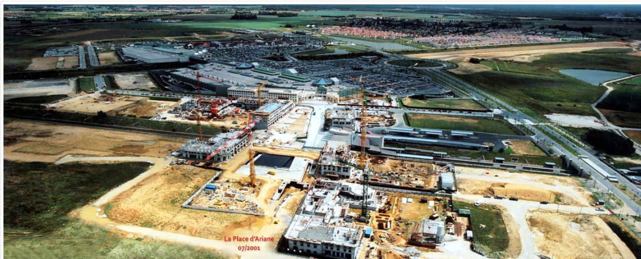
Figure 1: Chantier du centre urbain, juillet 2001(© EpaMarne / photo : Eric Morency)
